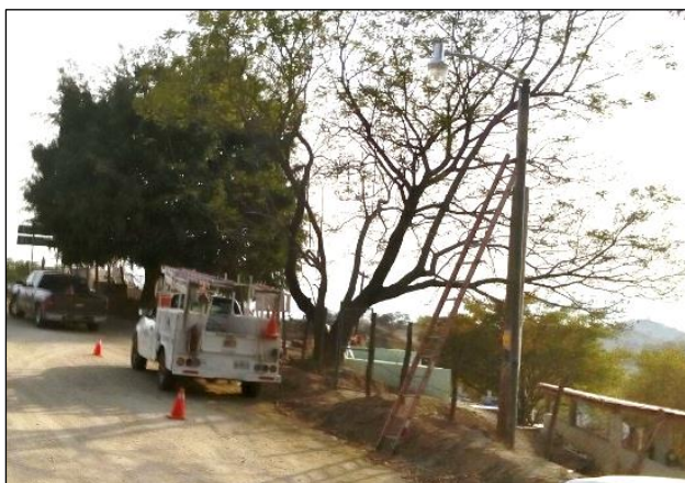
Imagen (1) de la colocación de 6 luminarias.
