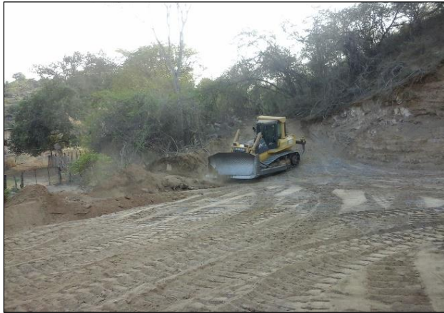
Camino de “Barranca del toro” a la localidad de “Cerro del Perico”, durante su rehabilitación.
