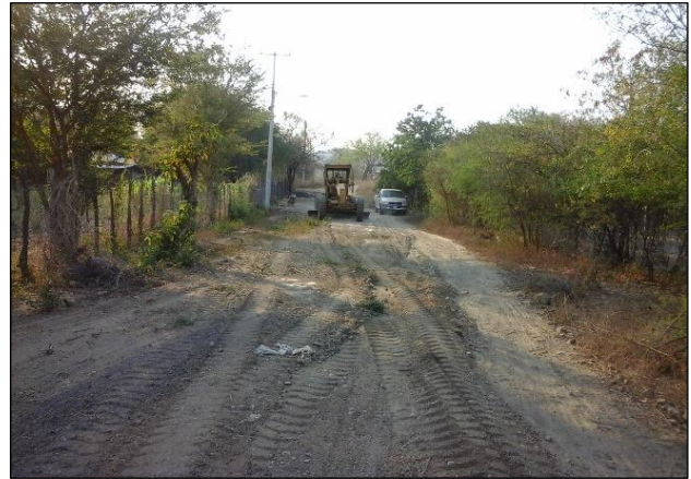
Camino de “El Terrero” a la localidad de “Ranchos Viejos” durante su rehabilitación.
