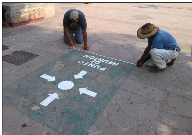
Pintado de señalización denominada: “Punto de Reunión”, señalado como punto de encuentro en caso de siniestro.
