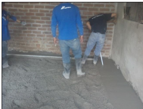
Aplicación de piso firme Cabecera Municipal.
