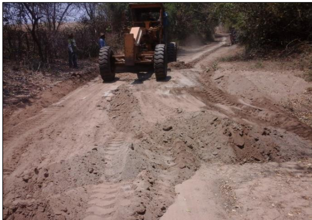
Camino de “El Terrero” a la localidad de “La Presa de Chilacán”, durante su rehabilitación.
