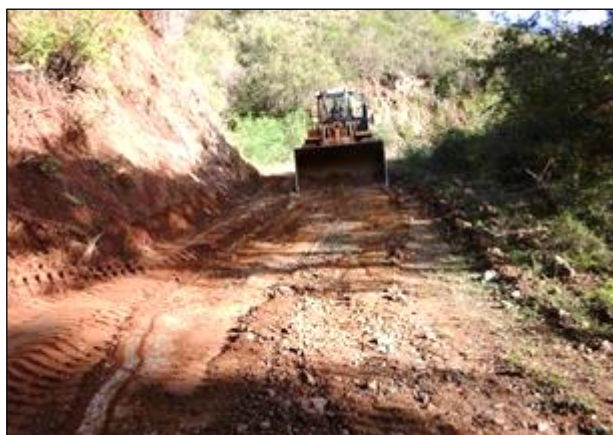
Camino a “Los Nogales” durante su rehabilitación
