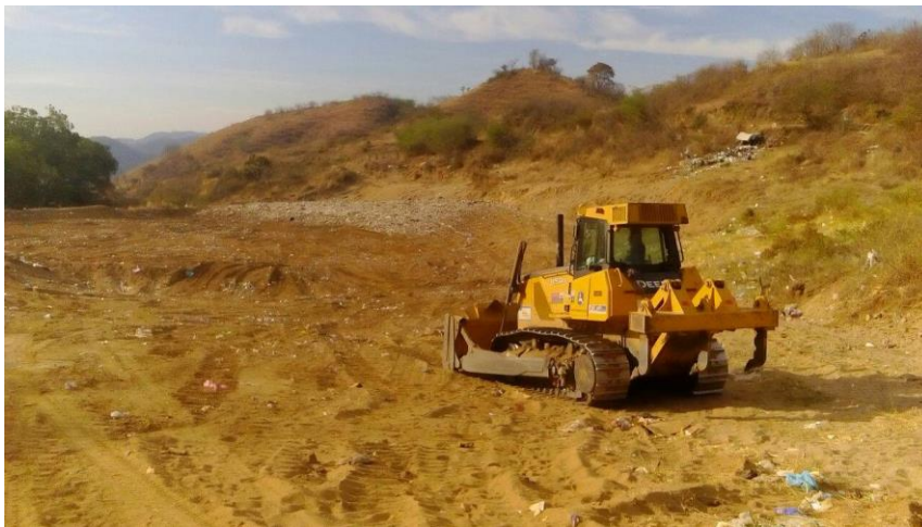
Mantenimiento al relleno Municipal.
