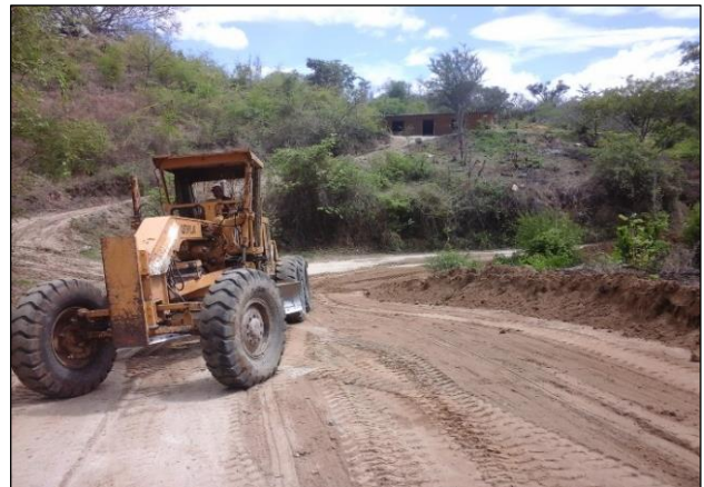
Camino de “El Rodeo” a la localidad de “El Rincón” durante su rehabilitación.
