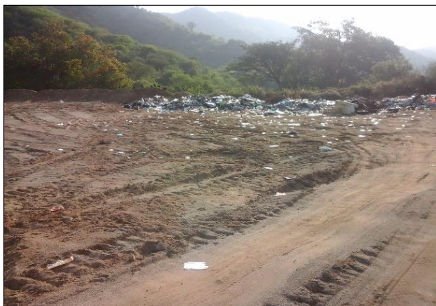
Mantenimiento y ampliación al basurero municipal. “Antes”.
