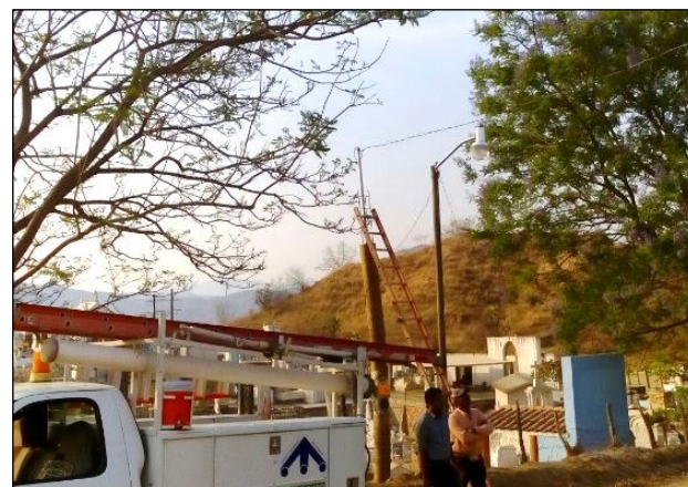
Imagen (2) de la colocación de 6 luminarias.
