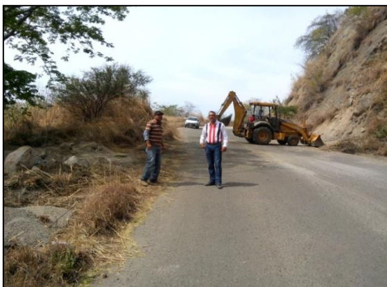
Se nos apoyo con una máquina para quitar algunos derrumbes y rocas grandes que obstruían un carril de las carreteras.
