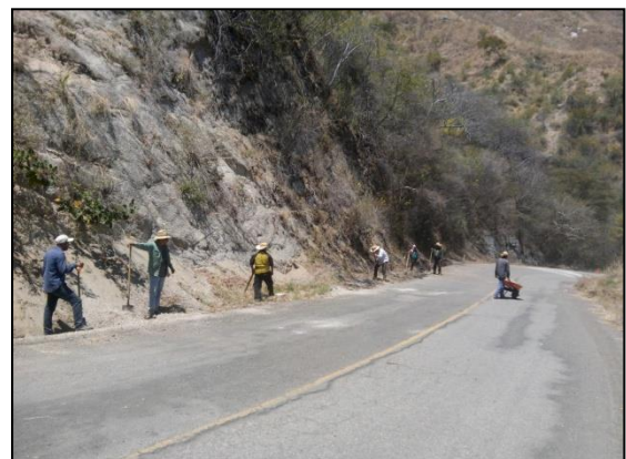
Personal del área de seguridad limpiando las cunetas de las carreteras.
