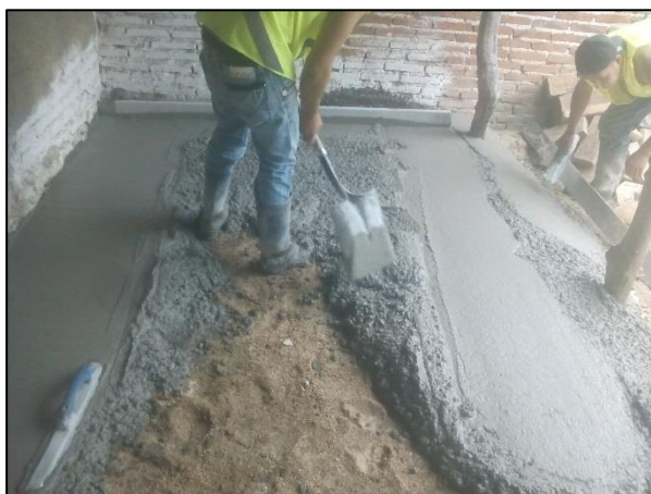
Aplicación de piso firme Cabecera Municipal.
